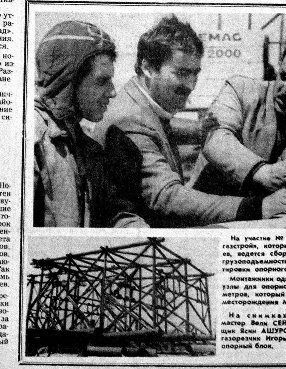
На участке № 1 СМУ-1 «Каспирнефтегазстрой», который руководит Рамиз Агаев, ведется сборка спускового понтона грузоподъемностью 450 тонн для транспортировки опорного блока по воде. Монтажные одноуровневые изготавляют узлы для опорного блока на глубину 130 метров, который будет спущен в районе месторождения М. Каверочкина. На снимках: прораб Ариф АББАСОВ, мастер Вели СЕЙДИХАНОВ, электросварщик Ясин АШУРОВ за чтемом чертежей; газорезчик Игорь КУТУКОВ; так выглядит опорный блок. Фото Р. НАГИЕВА.
