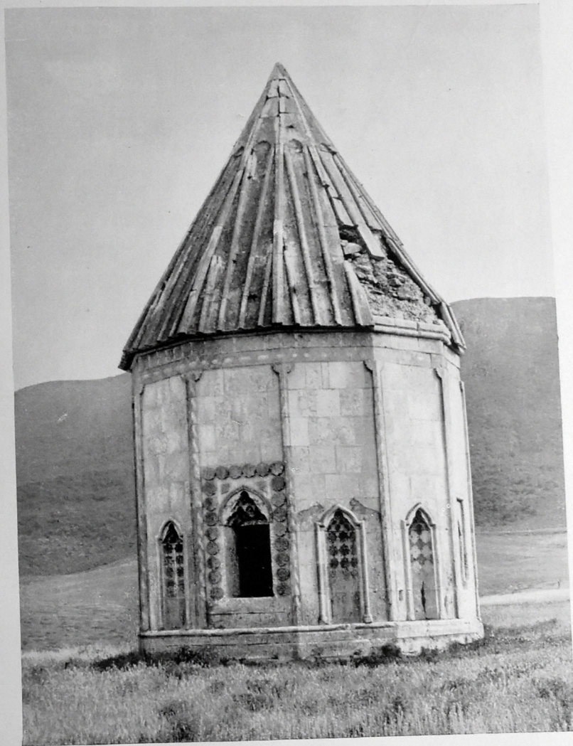
144. Сел. Хачин-Дорбатлы (Агдамский р-н). Мавзолей. 1314 г. Усад Шахбенер. Общий вид
